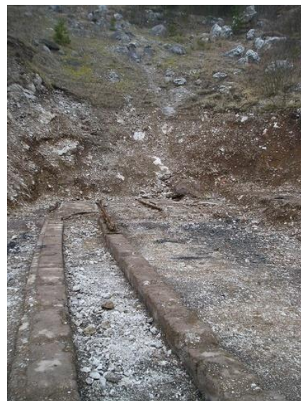
Podzemní továrna Mittelwerk u Nordhausenu, Německo - Koleje končící v závalu, jediné stopy po původním portálu tunelu A podzemní továrny Mittelwerk. Provoz byl zajištěn z převážné části skrze vězně z několikset metrů vzdáleného koncentračního tábora Dora-Mittelbau. (LCH 2013)
