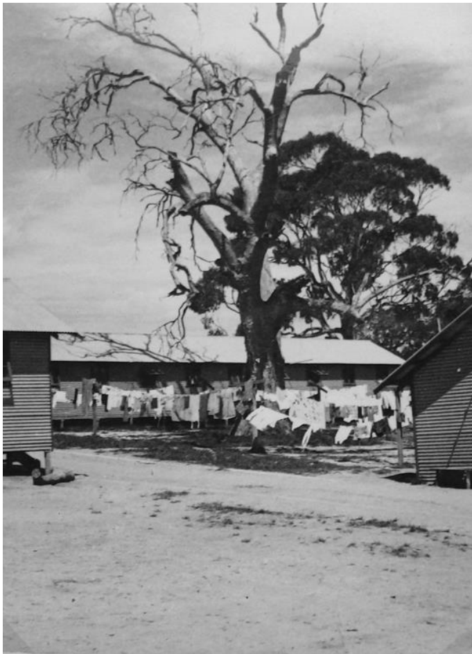
Typizované baráky z vlnitého plechu byly nejčastější formou ubytování válečných zajatců a internovaných v Austrálii.
