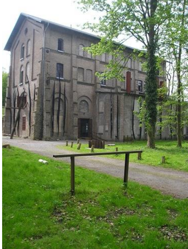
Augustschacht, Ohrbeck, Německo - Od roku 1940 byl v objektu kotelny a dělnických kasáren šachty August, zřízen tábor pro francouzské válečné zajatce. Komanda čítající 350 mužů bylo, v rámci pracovního komanda č.354 přiděleno z tábora Stalag VIC do provozu Kloeckner werke Georgmarienschacht (LCH2015)
