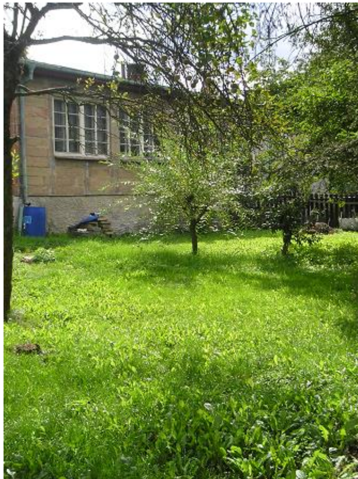
Internační středisko Třemošnice, obytný barák. Se stavbou bylo započato červenci 1945. Celkem bylo pozastaveno 9 zděných obytných baráků, kuchyně, nemocnice a dílny. Na stavbu byly přiváženy z plzeňských malých kasáren zajištěné osoby. Kolem celého areálu se nacházel plot s 6 strážními věžemi. Do ledna 1947 prošlo táborem přes 3000 osob z okresů Aš, Kraslice, Loket, Planá, Stříbro a Tachov, mimo jiné zde bylo i dočasně umístěno 265 válečných zajatců. (LCH2013)
