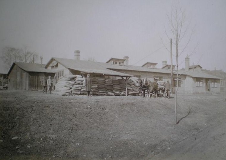
Desinfekční a odšívovací barák, Ostrava Vítkovice (Foto: Archiv Vítkovice a.s.)
