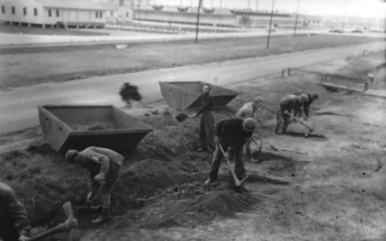
Němečtí zajatci nasazeni na kopání odvodňovacích kanálů na vojenské základně Camp Campbell
