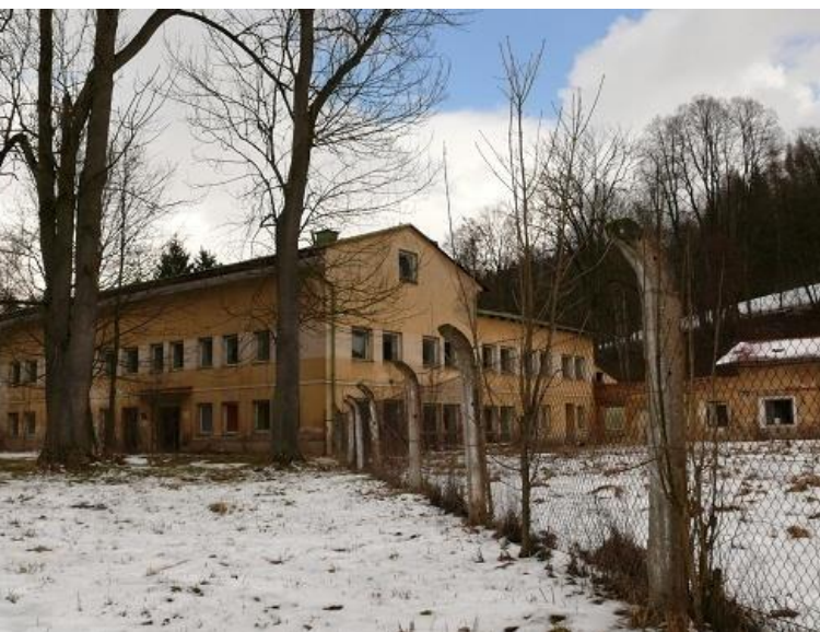
Libeč, Budova bývalých kanceláří přádelny lnu K.H.Barthela - Během Druhé světové války zde bylo ubytováno britské pracovní komando podřízené kmenovému zajateckému táboru Stalag VIII A. Komando sestávalo z 26 britských válečných zajatců nasazených ve zmiňované přádelně (LCH2008).
