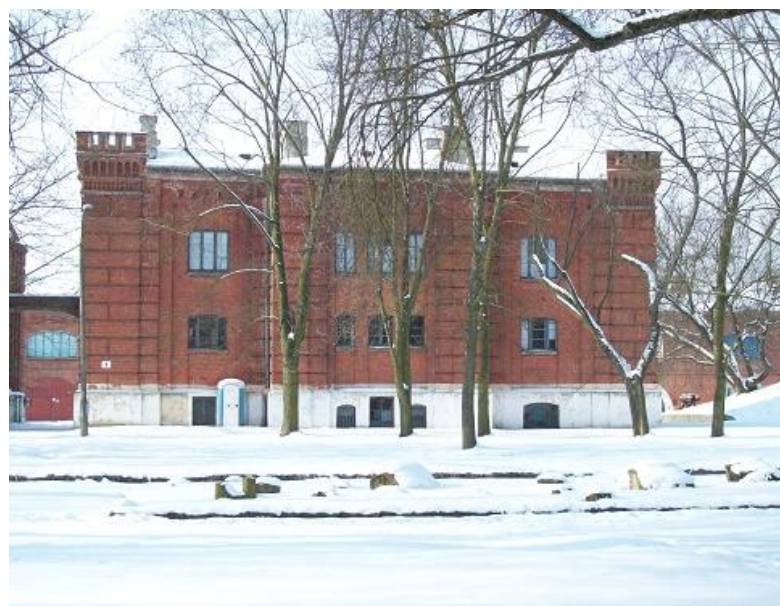
Deblin, Polsko, bývalá pevnostní pekárna uvnitř citadely (Foto:Jerzy Trzaskowski)
