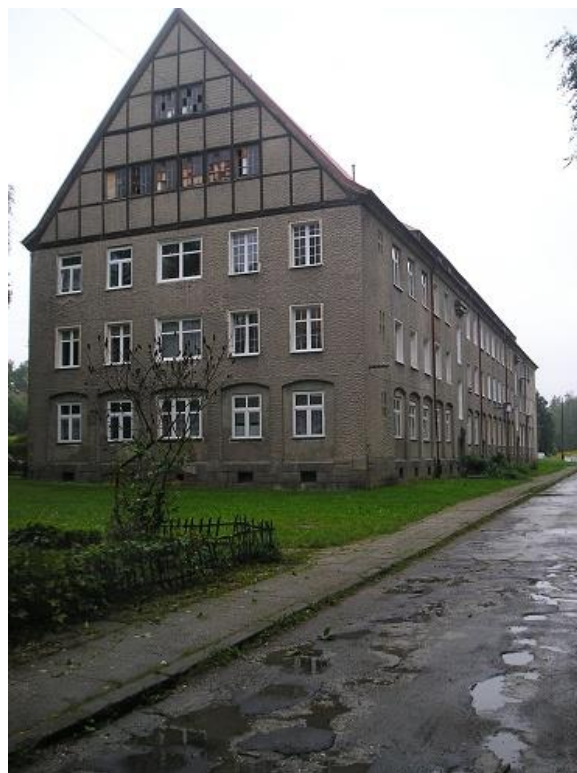
Kasárny v obci Sieniawka, Polsko - V období Druhé světové války byl v kasárnách zřízen obří pracovní tábor a provoz firmy Zittwerke, Zittau-Kleinschönau. Sem přidělená pracovní komanda byla podřízena kmenovému táboru Stalag VIII A. (LCH2014)
