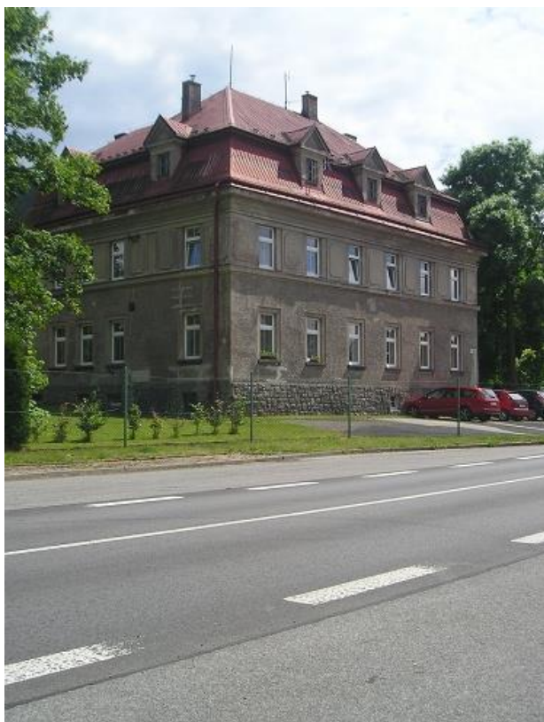
Bývalá kasárna finanční stráže Královec - Během Druhé světové války bylo v budově ubytováno britské pracovní komando, podřízené kmenovému zajateckému táboru Stalag VIII A. Komando sestávalo z 35 mužů nasazených u říšských drah. (LCH2014)
