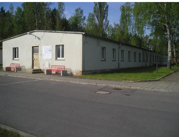
Elsterhorst, Německo - Poslední z původně 6 baráků zajateckého lazaretu. V táboře celkem zemřelo 255 zajatců. (LCH2015)
